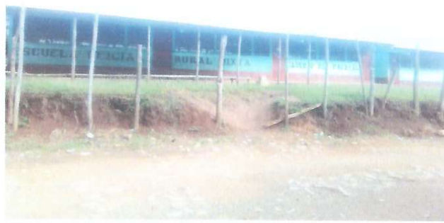
Foto 3: Cerco perimetral de EORM Caserío El Pacayal
